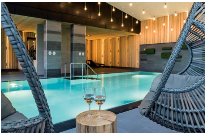
Bild linke Seite Unzählige Lampen beleuchten den modernen Salzwasserpool. Der Pool enthält solebeständige Spezial-Einbauteile von Behncke.
